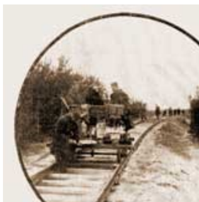
Zdjęcie z budowy kolei do Helu, zamieszczone w Kurierze Ilustrowanym z roku 1921.
